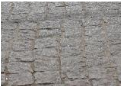
Εικόνα 20. Κυβόλιθοι από φυσικό πέτρωμα-γρανίτη χρώματος γκρί με ανάγλυφη επιφάνεια διαστάσεων 20x20εκ. , πάχους 6 εκ.
