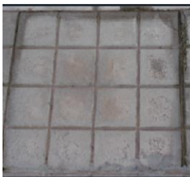
Εικόνα 12. Πλάκα πεζοδρομίου τύπου καλντερίμι (τσιμεντόπλακα), χρώματος γκρί διαστάσεων 40x40cm πάχους 4 εκ.
