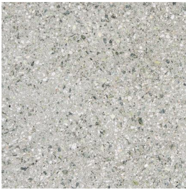
Εικόνα 2. Κατασκευή έγχρωμου χυτού βοτσαλωτού δαπέδου, σε αποχρώσεις του γκρι
