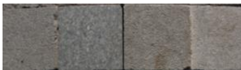
Εικόνα 13. Κυβόλιθοι από φυσικό πέτρωμα γρανίτη χρώματος γκρί με επίπεδη αντιολισθηρή επιφάνεια, διαστάσεων 20x20cm, πάχους 6 εκ.
