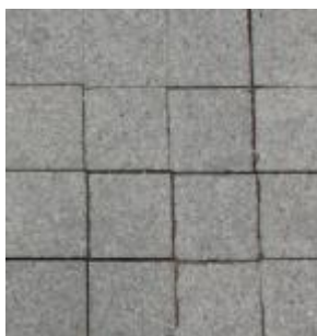
Εικόνα 14. Κυβόλιθοι από φυσικό πέτρωμα γρανίτη χρώματος γκρί με επίπεδη αντιολισθηρή επιφάνεια, διαστάσεων 10x10cm, πάχους 6 εκ.
