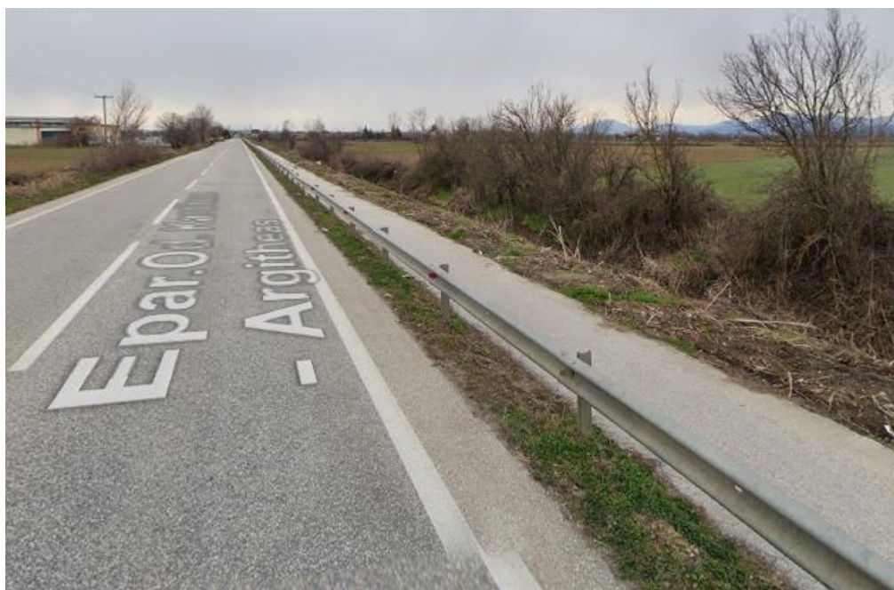
Εικόνα 20: Ποδηλατόδρομος επί της Επαρχιακής Οδού Καρδίτσας – Μουζακίου (Πηγή: Google maps)
