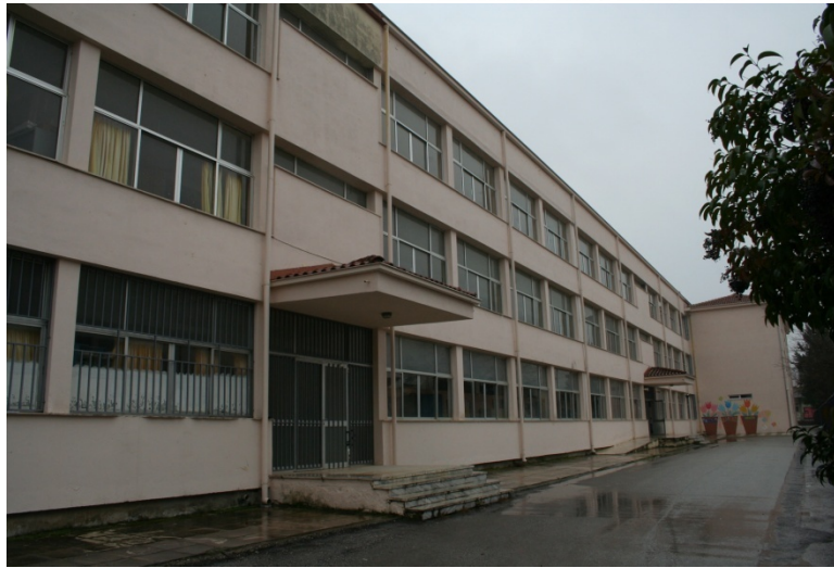
Εικόνα 1.1: Άποψη της κεντρικής εισόδου (Ανατολικά) και της βοηθητικής εισόδου (Δυτικά)
