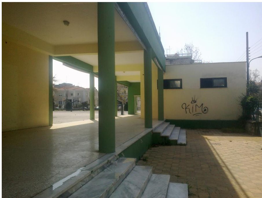
ΦΩΤ. 7 : Βόρεια όψη WC
