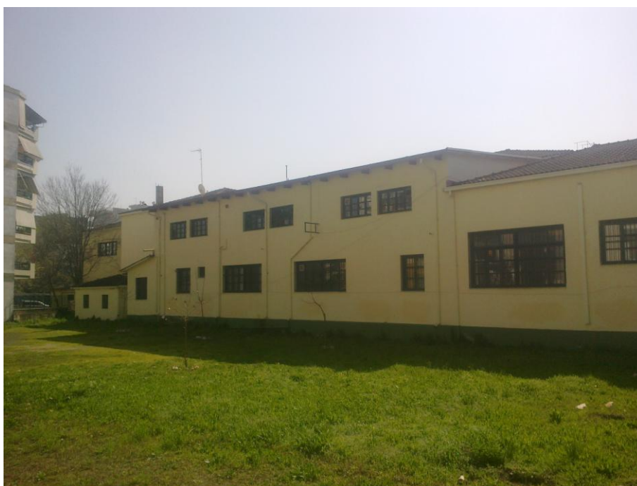
Φωτ. 12 : Βόρεια όψη
