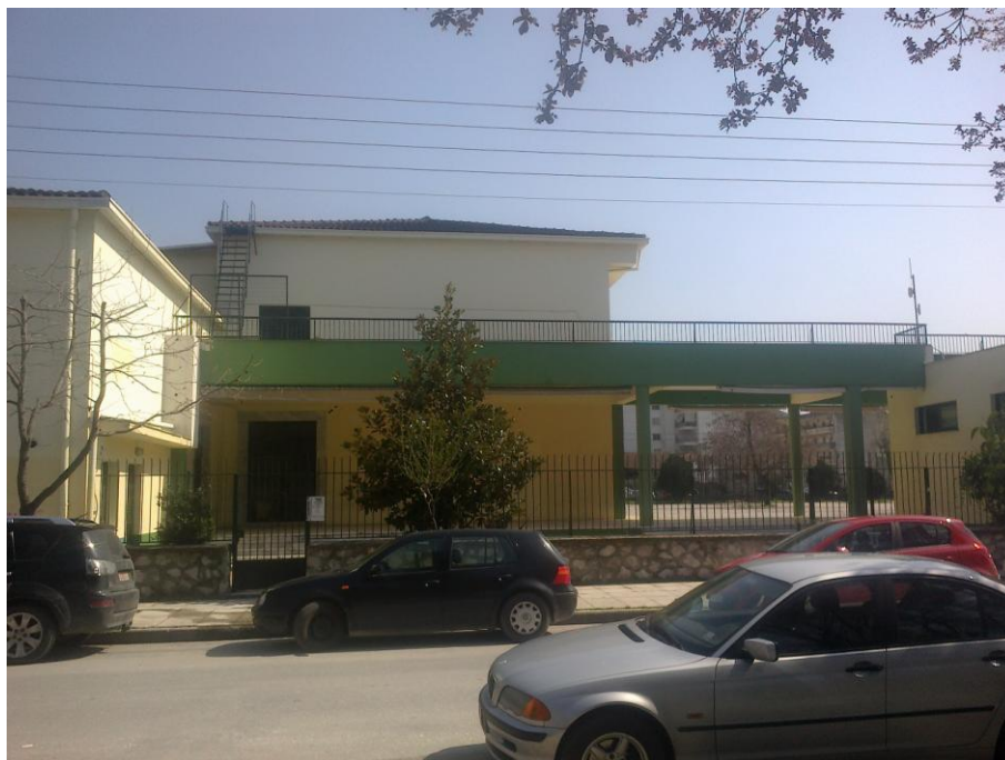
Φωτ. 5 : Δυτική όψη
