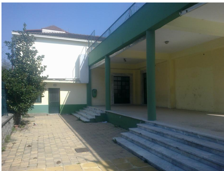
Φωτ. 6 : Νοτιοδυτική όψη Εισόδου
