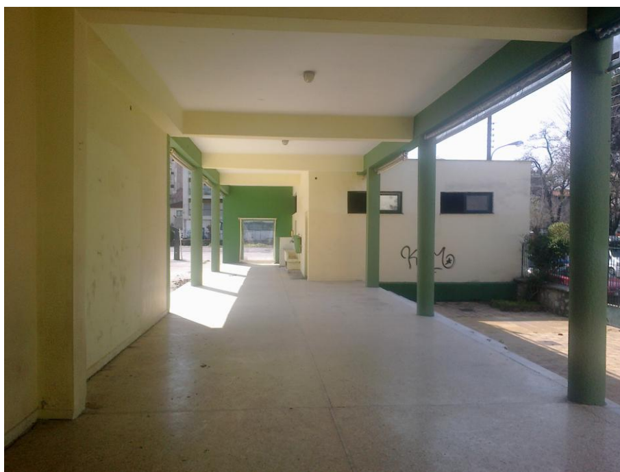
ΦΩΤ. 8 : Βόρεια όψη WC και Ημιυπαίθριου χώρου
