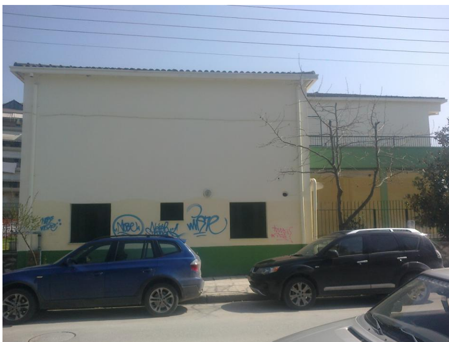
Φωτ. 4 : Δυτική όψη
