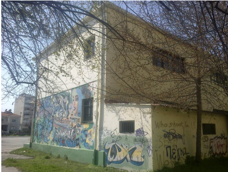
Φωτ. 13 : Βορειοανατολική όψη
