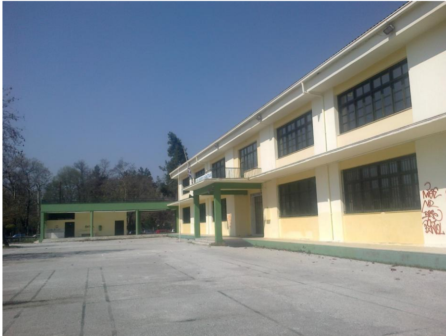
Φωτ. 3 : Νότιοανατολική όψη κτιρίου και WC
