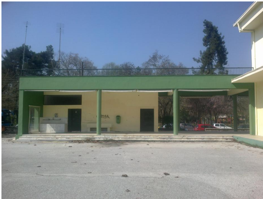
Φωτ. 10 : Ανατολική όψη WC
