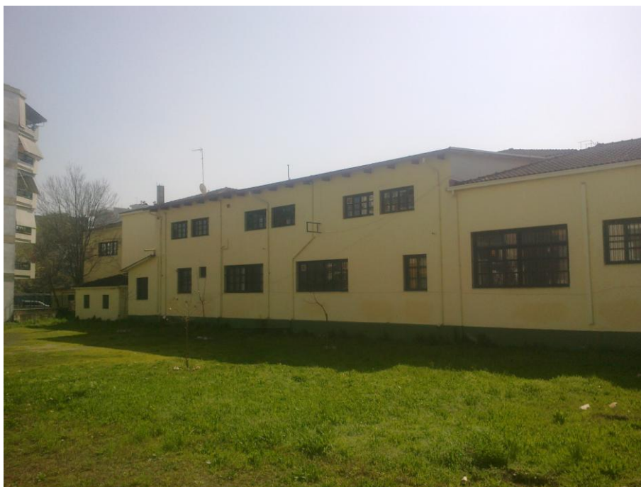
ΦΩΤ. 12 : Βόρεια όψη
