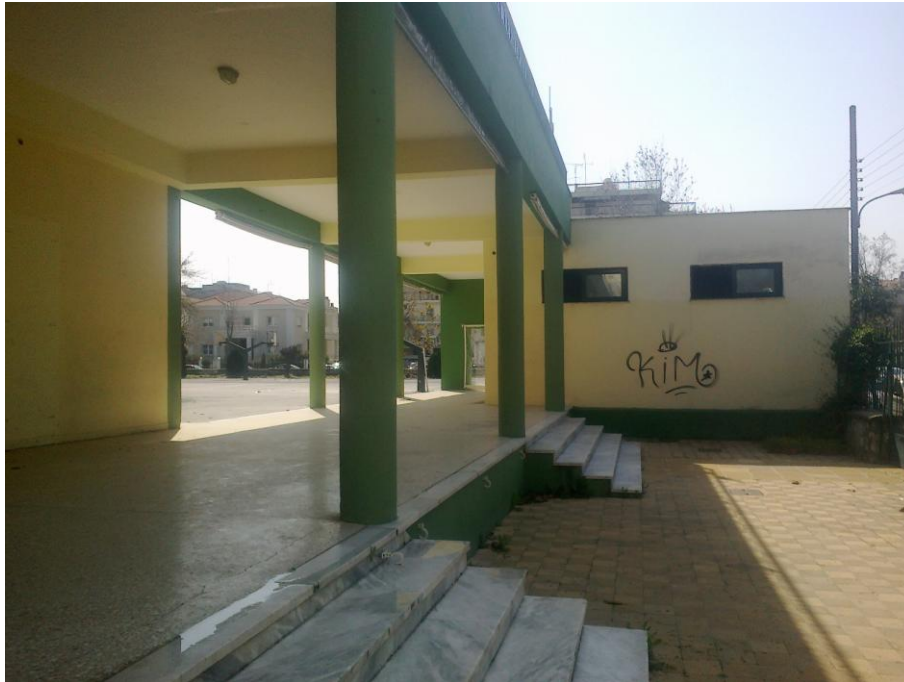
ΦΩΤ. 7 : Βόρεια όψη WC
