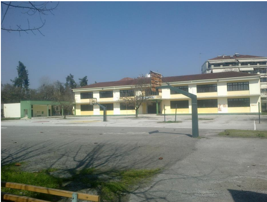
Φωτ. 2 : Νοτιοανατολική όψη
