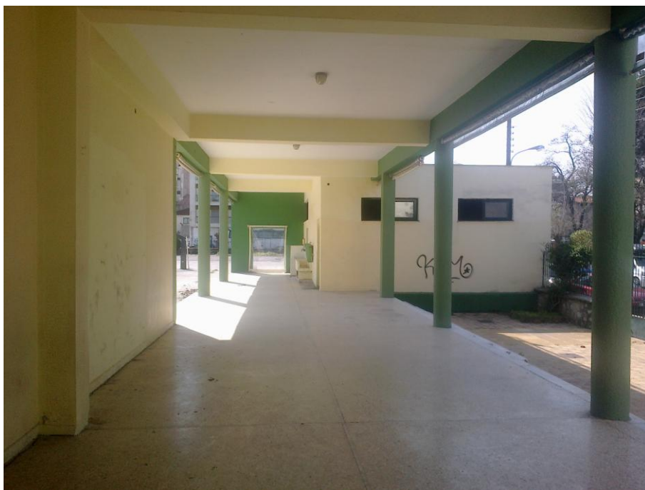
ΦΩΤ. 8 : Βόρεια όψη WC και Ημιυπαίθριου χώρου
