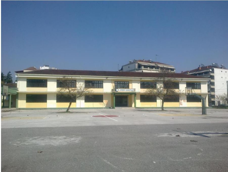
Φωτ. 1 : Νότια όψη
