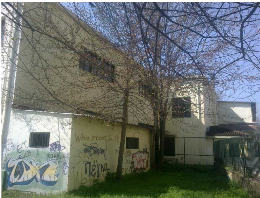
Φωτ. 14 : Βορειοανατολική όψη
