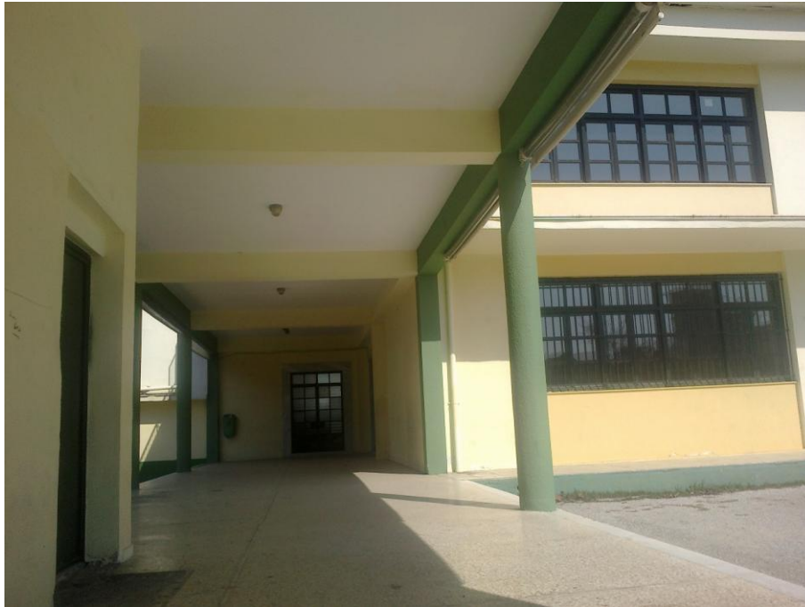
Φωτ. 9 : Νότια όψη Ημιυπαίθριου χώρου και Εισόδου
