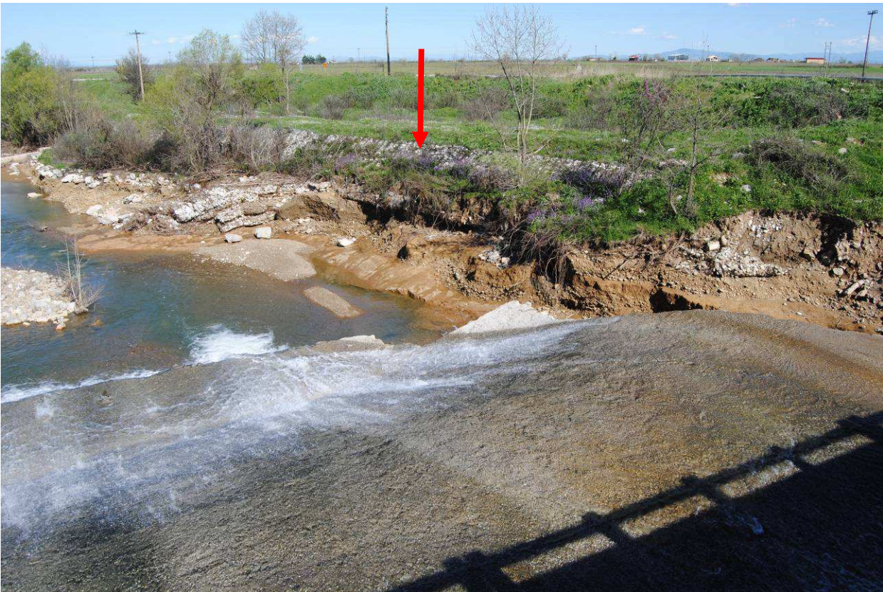
Εικ.6.5.4 Διευθέτηση - προστασία της δεξιάς κοίτης του Καράμπαλη με συρματοκιβώτια, λόγω διάβρωσης των νερών του – υψηλές ταχύτητες ροής.
